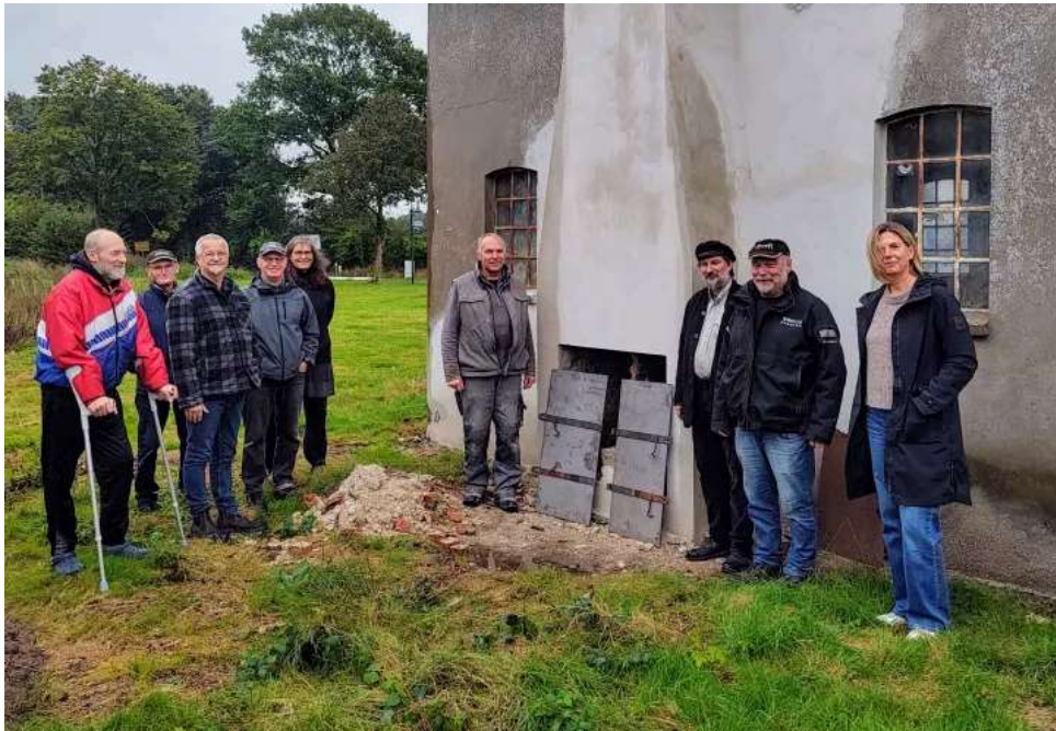
Beate von Malottky von der unteren Denkmalschutzbehörde (von rechts), Bürgermeister Harro Kruse sowie Arne Paysen freuen sich gemeinsam mit weiteren Unterstützern über die von einer Stiftung finanzierten Revisionsklappen für den Schornstein. Diese wird Volker Hansen (Mitte) einbauen. FOTO: CHRISTIAN LIPOVSEK
